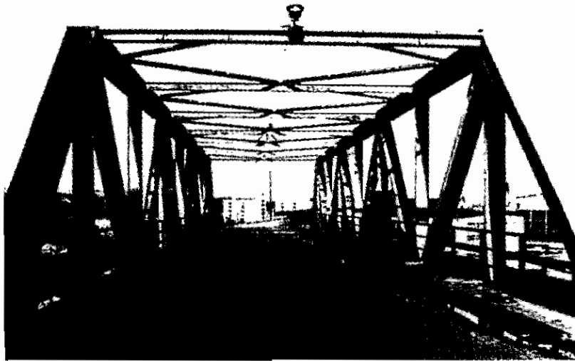
Obr. 6.24 První celosvařovaný most příhradové konstrukce
